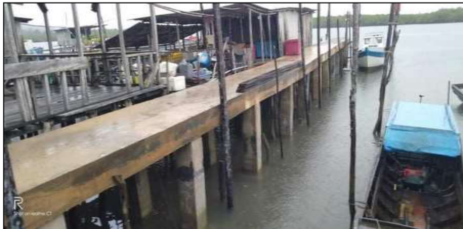
Gambar 1. Pembangunan Fasilitas Tambatan Kapal Nelayan di Pulau Selat Limau
