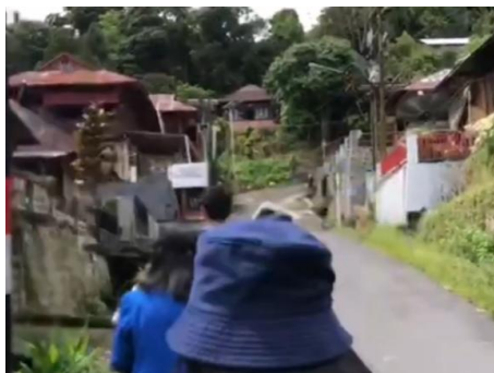
Gambar 2. Kondisi Jalan Desa Sudah Beraspal
